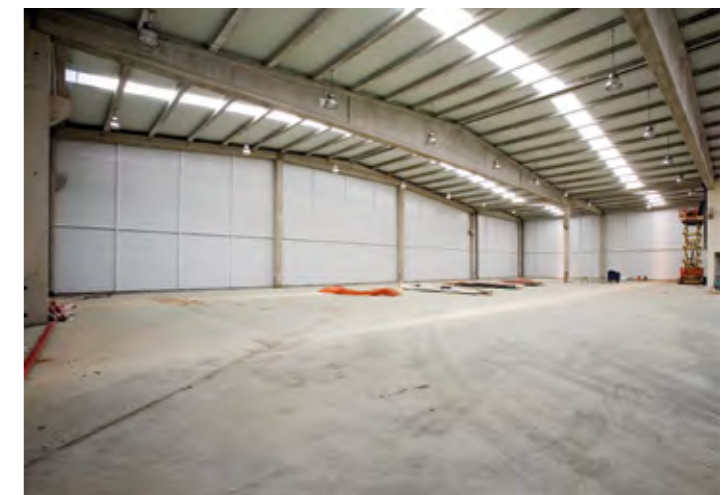
PAVILHÕES INDUSTRIAIS IZMAR IZMAR INDUSTRIAL WAREHOUSES VIGO
